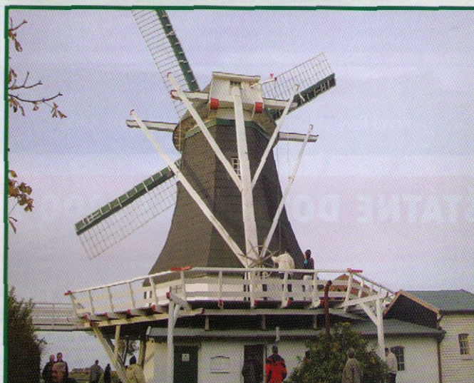
Pohled zezadu s mechanismem ručního natáčení celé „kopule“ s lopatkami proti větru
